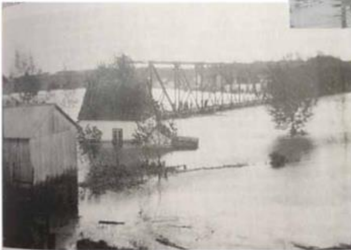
Inondation près du pont sur la route Saint-Denys-Garneau - 1924
